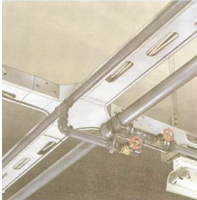
Ανάρτηση σχάρας στην οροφή
